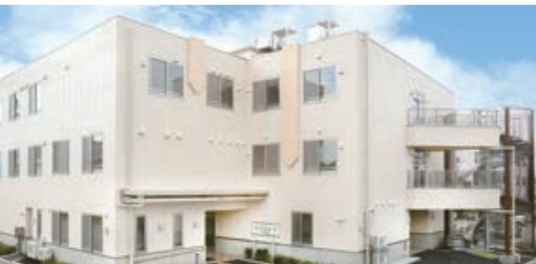
結いまある井川城 外観
